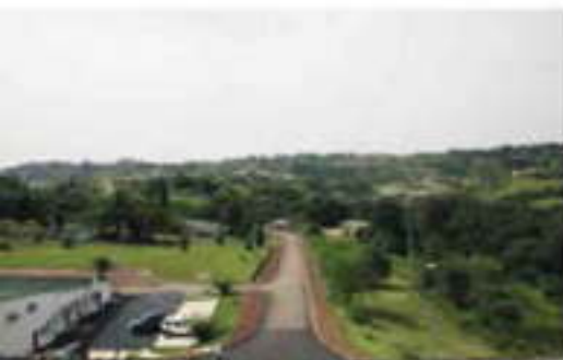
Abb. 1. Anlagenkomplex des Medizinischen Forschungszentrums CIRMF, Franceville
